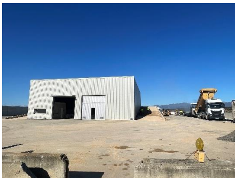
Foto de la futura deixalleria comarcal
