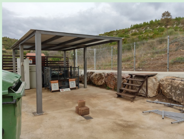
Enguany s'han fet millores a les deixalleries de Biure, Cabanelles, Navata, Ordis, Agullana, el Port de la Selva i Vilamallà gràcies a la subvenció de deixalleries de l'ARC. Algunes d'aquestes obres són ampliacions de les instal·lacions, construcció de nous coberts i casetes d'especials, automatitzacions del sistema d'entrada a la deixalleria, implantació de bàscules, etc.
